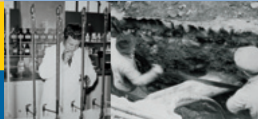
Links: Das alte Labor zur Kontrolle der Trinkwasserqualität, um 1967. Rechts: Mitarbeiter der Stadtwerke Iserlohn stoßen bei Erdarbeiten auf alte Holzwasserleitungen
