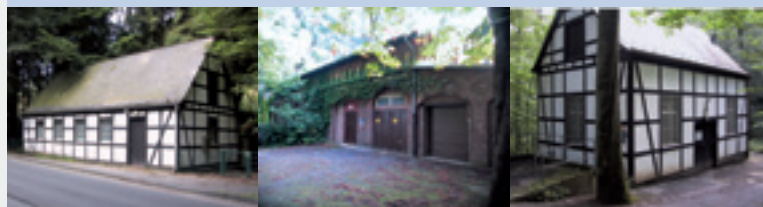
Die weiteren Rohwassergewinnungsanlagen neben dem Krug von Nidda: RWG Lägertal, RWG Westig und RWG Wermingsertal
